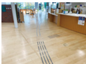
屋内の低突起の誘導用点字タイル
